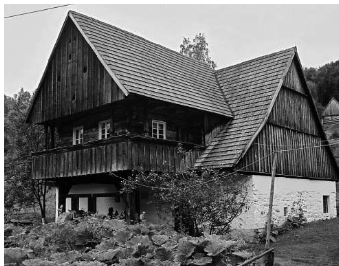
Pstrážna, skansen. Dom z wyżką z poł. XIX wieku. Wieńcowo-murowana konstrukcja ścian. (Fot. autor, 2006)
