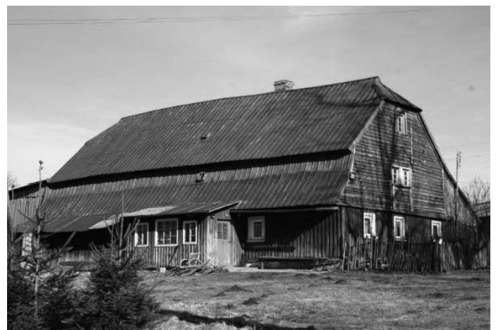
Lasówka. Budynek wiejski o konstrukcji wieńcowej ścian pokrytych deskami. Dach mansardowy z naczółkiem. (Fot. autor, 2012)
