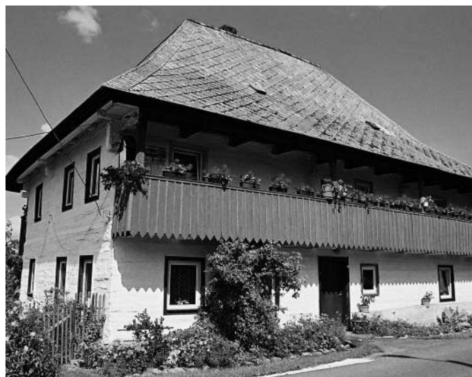
Lasówka. Piętrowy budynek o konstrukcji ryglowej ścian pokrytych deskami. XIX wiek. (Fot. autor, 2009)
