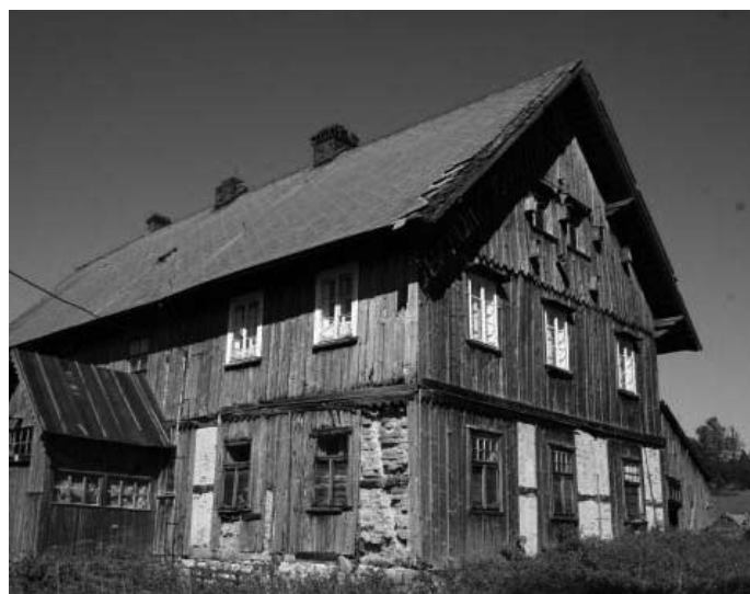
Zieleniec. Jeden z niewielu zachowanych XIX wiecznych budynków regionalnych (Fot. autor, 2010)
