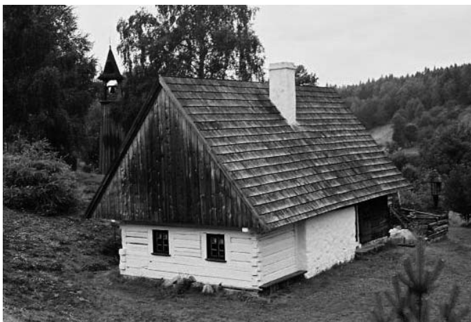
Prązna, skansen. Dom wiejski o konstrukcji wieńcowej ścian i stromym dwuspadowym dachu. (Fot. autor, 2006)
